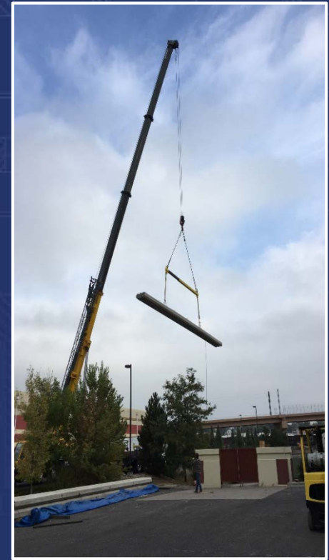
TES Block Placement
